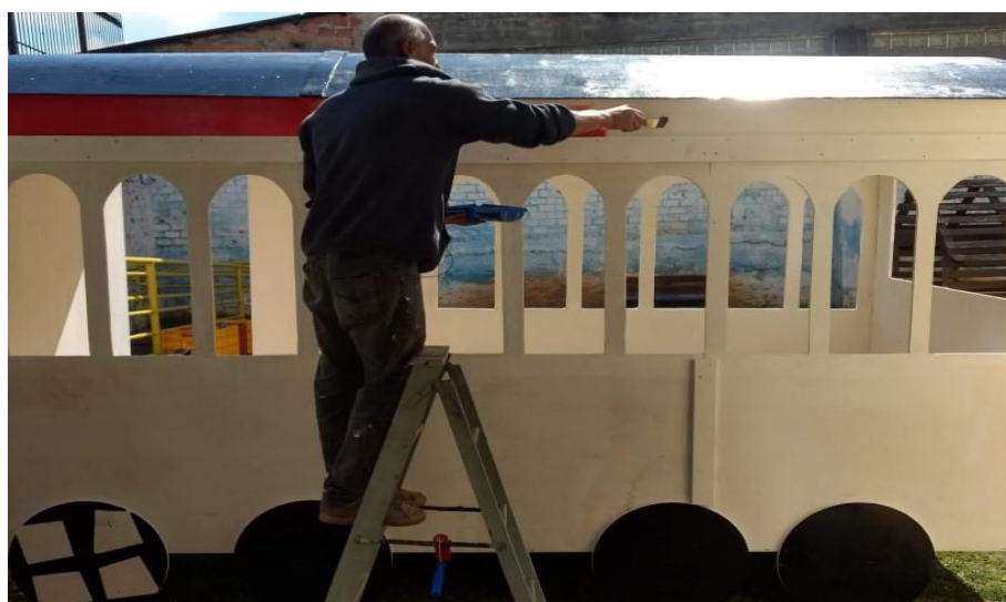
Figura 2: Construção e pintura do Espaço de Brincar “Trem”
