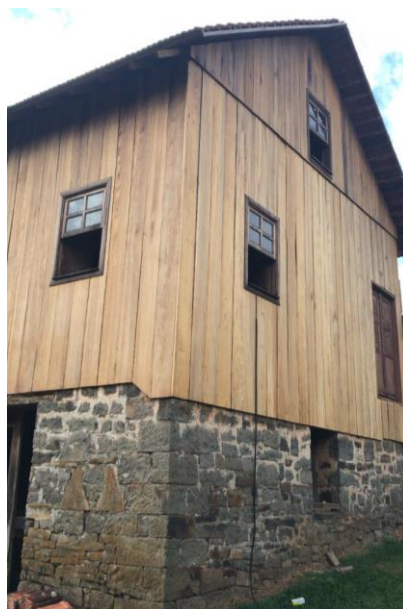
Figura 2: Vista lateral do casarão durante o processo de restauro.
