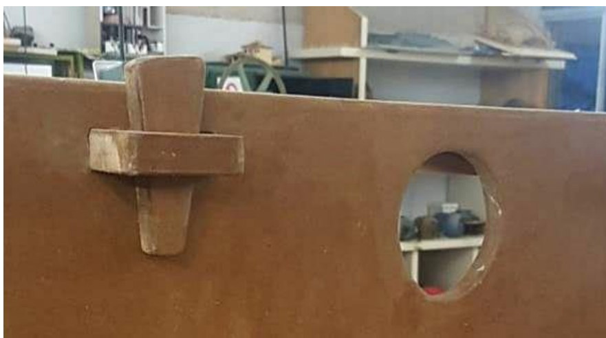
Figura 6: Detalhe do travamento do mobiliário por cunhas
