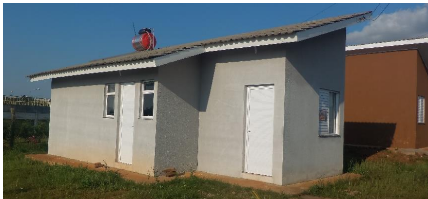
Figura 16: Edificação “embrião” construída.
