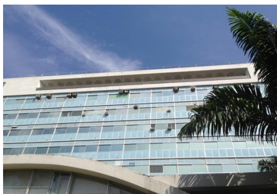
Figura 14: Detalhe para o prédio principal.
