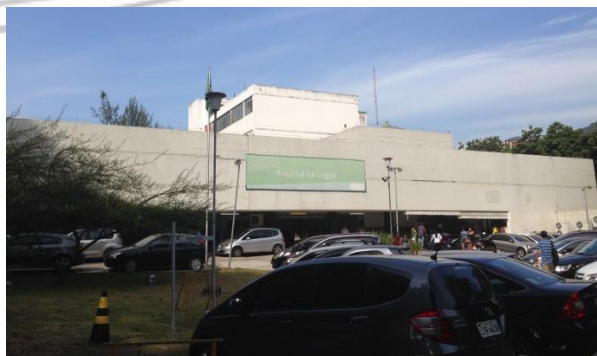
Figura 15: Vista do anexo da fachada referente a rua Oliveira Rocha.
