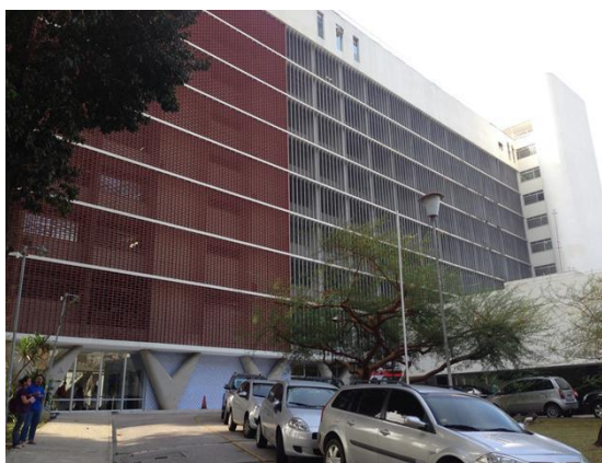
Figura 17: Prédio principal do Hospital da Lagoa.
