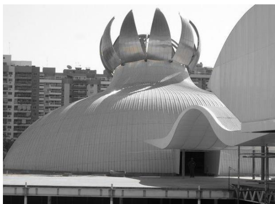
Figura 22: Vista externa do auditório do hospital
