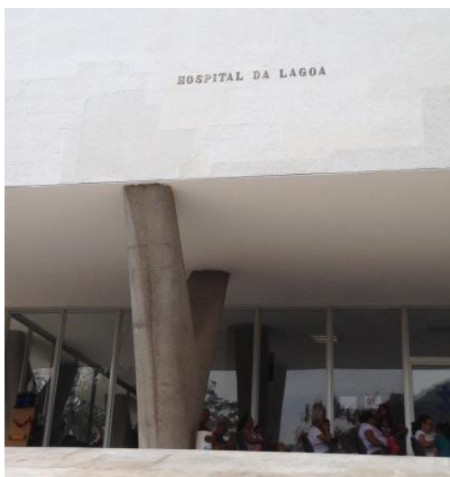
Figura 16: No prédio principal, sobre o pilotis, letras antigas identificando o Hospital da Lagoa.
