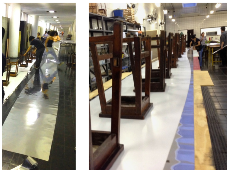
Figura 5: Corte do Mylar (Metalizado) com Auxílio de um Gabarito (Cor Branca)
