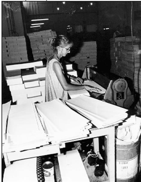
Figura 5 = Demonstração de postura da operária em pé e frente a máquina de perfurar blocos e cadernos. Fonte = Flavio Bini Bortoloti.
